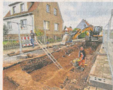
In der Goethestraße in Heldrungen haben die Kanalbauarbeiten begonnen.
